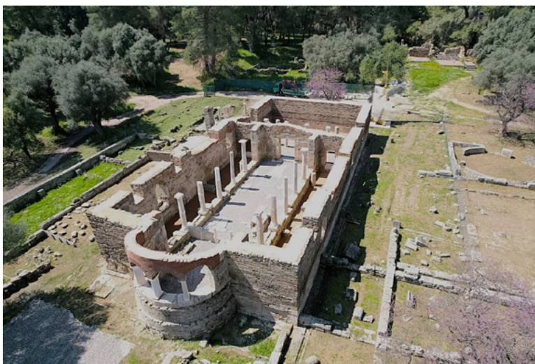
FIDIJEVA DELAVNICA V OLIMPIJI (V REKONSTRUKCIJI)
